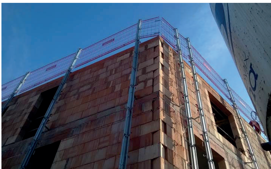
Exemple d'utilisation sur un chantier de murs en brique.
