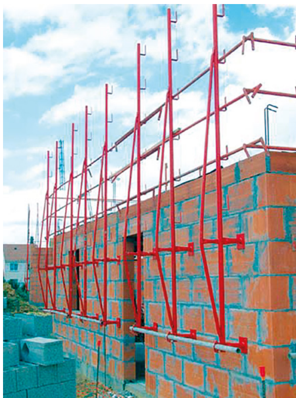
Protection maçon grimpante sur un chantier.
