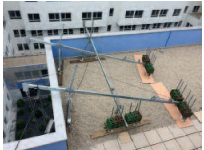
Figure 7. Poutres de suspension sur terrasse (© SFECE).
