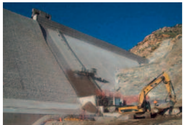
Figure 45. Opération de rénovation d'un barrage (mât installé sur une surface en pente non verticale) (© SFECE).
