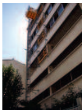
Figure 49. Monte-matériaux vu de dessous (© SFECE).
