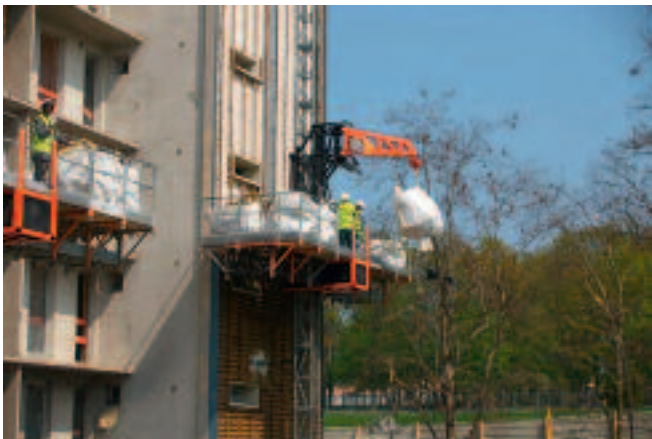
Figure 41. Potence et treuil d'approvisionnement sur mono-mât (approvisionnement en autonomie sans engin au sol) (© SFECE).
