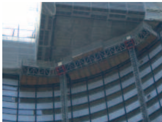
Figure 47. Extensions circulaires épousant la surface concave du bâtiment (© SFECE).
