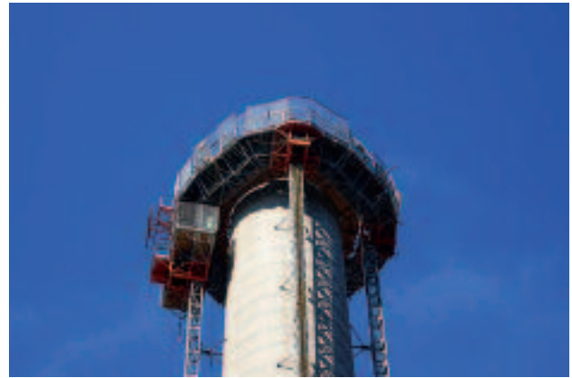
Figure 43. Opération de démolition de cheminée (chute de gravats et engin de démolition sur la plate-forme) (© SFECE).
