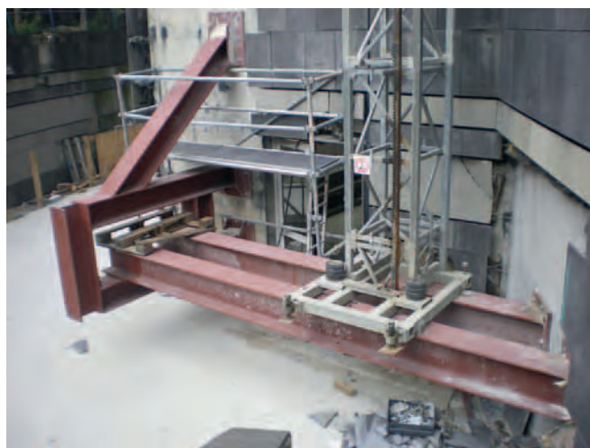
Figure 39. Châssis sur console (© SFECE).
