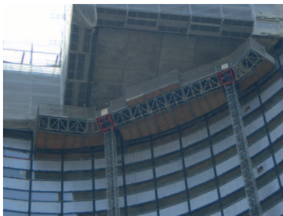
Figure 47. Extensions circulaires épousant la surface concave du bâtiment (© SFECE).
