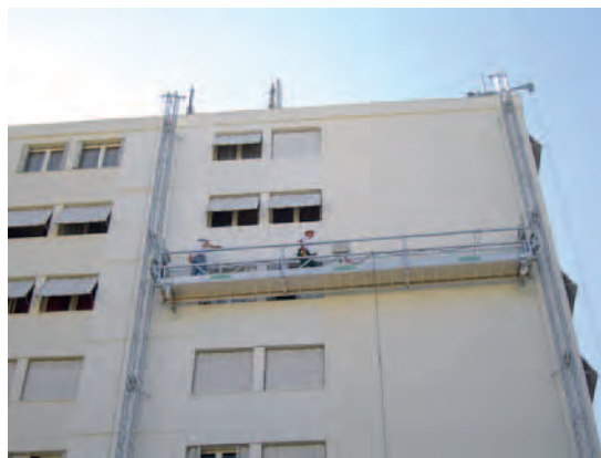
Figure 10. Plate-forme suspendue sur mâts (© SFECE).
