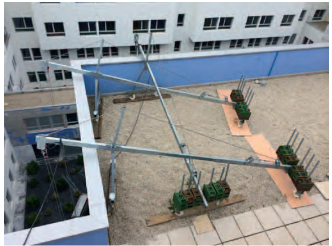
Figure 7. Poutres de suspension sur terrasse (© SFECE).
