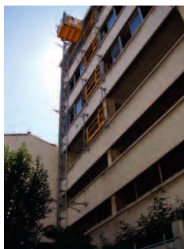
Figure 49. Monte-matériaux vu de dessous (© SFECE).
