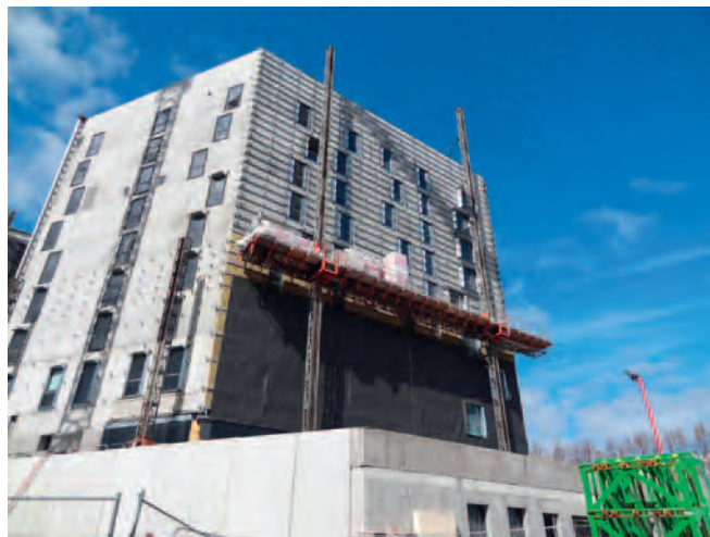
Figure 33. Plate-forme sur mât (© SFECE).
