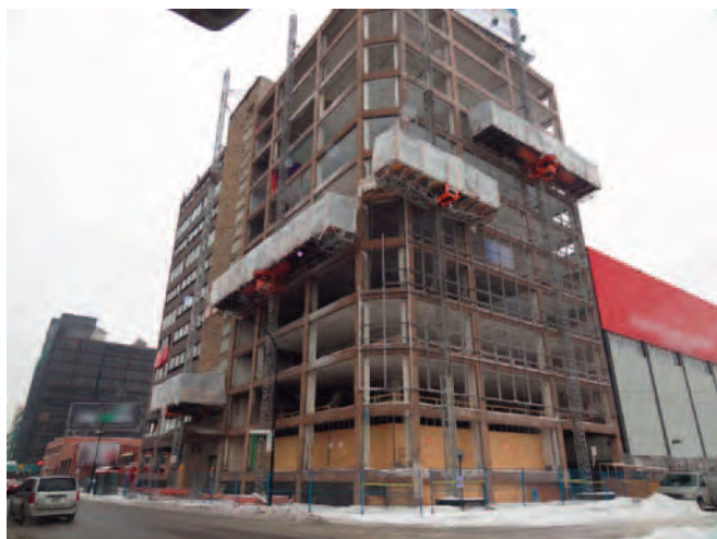
Figure 42. Plates-formes dotées de toilage et de chauffage (maintien de l'activité par grand froid) (© SFECE).
