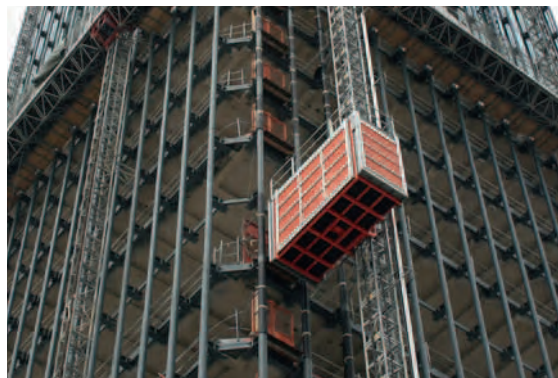
Figure 55. Ascenseur de chantier installé pour desservir un ouvrage de grande hauteur (© SFECE).
