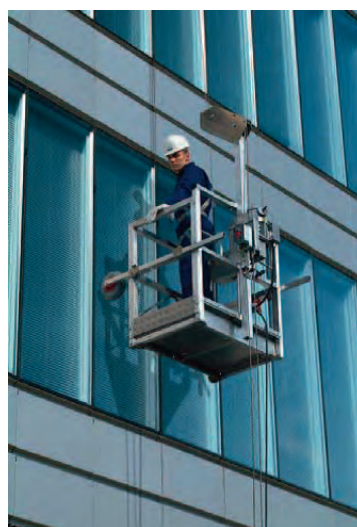
Figure 18. Nacelle en phase d'exploitation (© SFECE).
