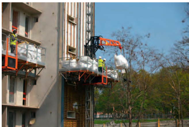
Figure 41. Potence et treuil d'approvisionnement sur mono-mât (approvisionnement en autonomie sans engin au sol) (© SFECE).
