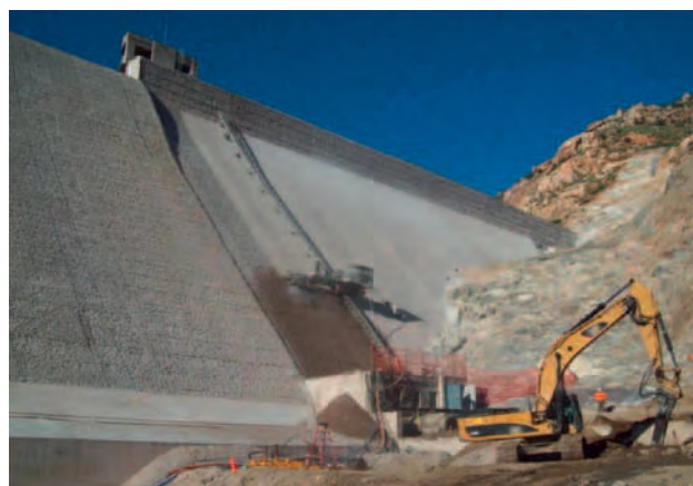
Figure 45. Opération de rénovation d'un barrage (mât installé sur une surface en pente non verticale) (© SFECE).
